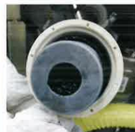
バイオクリーン未使用の排水トラップ内部
