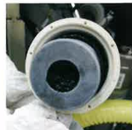
バイオクリーン未使用の排水トラップ内部
